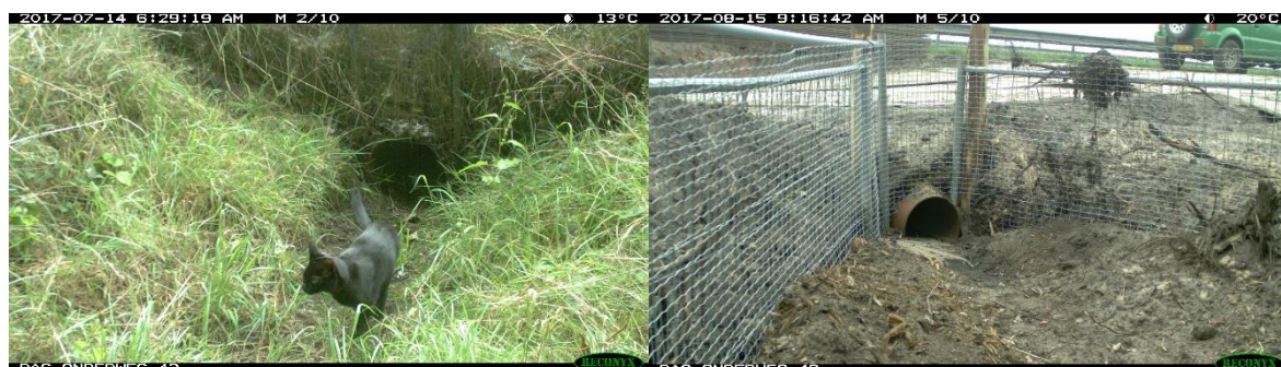
Westkant van de tunnel ten zuiden van Hollandsche Rading, kort voor de verlenging (links) en kort er na, met verbeterd dassengaas (rechts).
