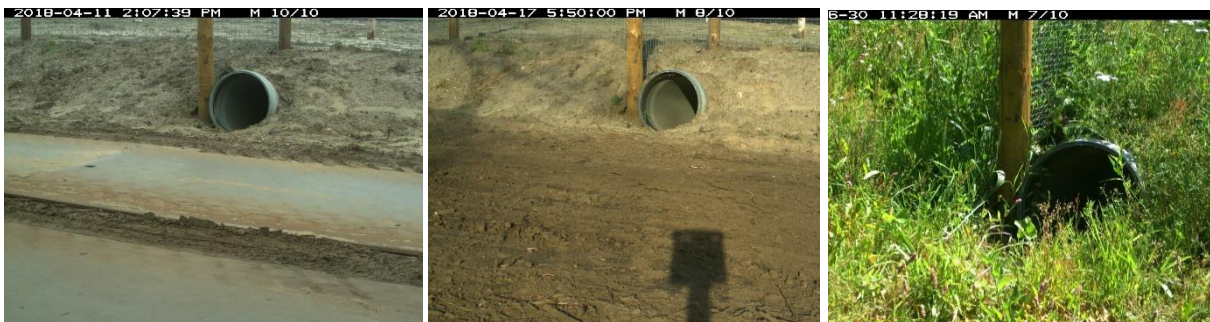
Het veranderende uiterlijk van de westelijke ingang van de tunnel ten zuiden van Maartensdijk. Van links naar rechts resp. tot half april (met rijplaten), na half april, en eind juni 2018.
