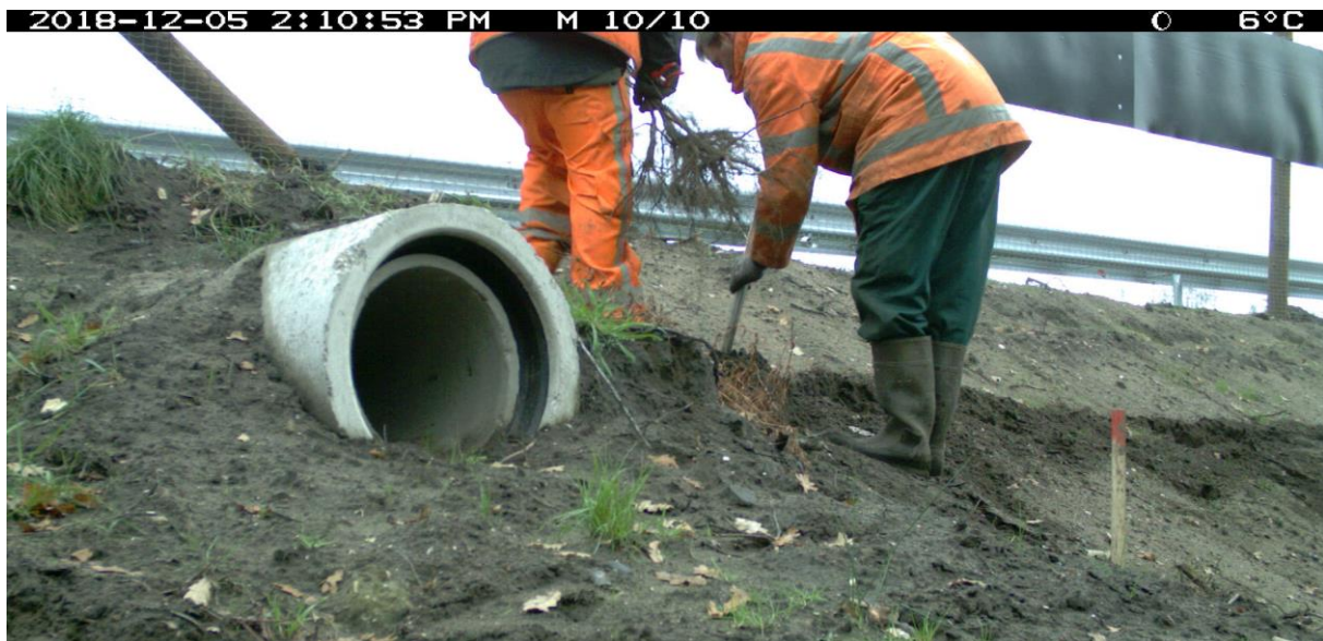
Aan de westkant van dassentunnel Bosberg wordt de laatste hand gelegd aan de nieuwe berm, boompjes worden ingeplant. Hier is ook het nieuwe dassen-boommarter-raster te zien, met een gladde zwarte laag kunststof om boommarters te verhinderen er overheen te klimmen. Dit type raster staat overal langs het beboste gedeelte van de A27, tussen Hollandsche Rading en knooppunt Eemnes.
