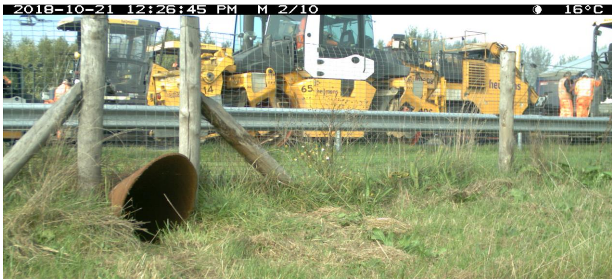
De A27 wordt geasfalteerd ter hoogte van Groenekan, 21 oktober 2018.
