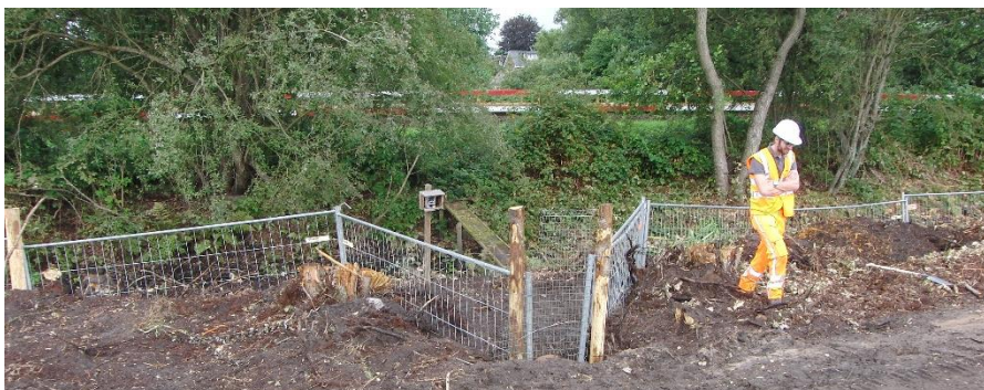
Tijdelijk situatie aan de westkant van de tunnel ten zuiden van Hollandsche Rading, met te grove hekken, op 28 juli 2017.
