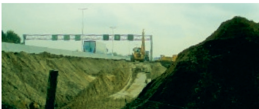
Foto 4. Grootchalig grondwerk bij dassentunnel 1. Foto genomen vanaf het punt van de wildcamera bij de tunnel in week 44. Foto: Jaap Mulder.
