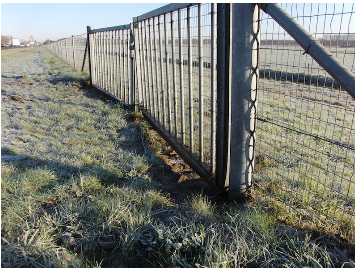
Slecht sluitende en openstaande hekken in het dassenraster zijn jaarlijks verantwoordelijk voor verkeersslachtoffers onder de dassen.
