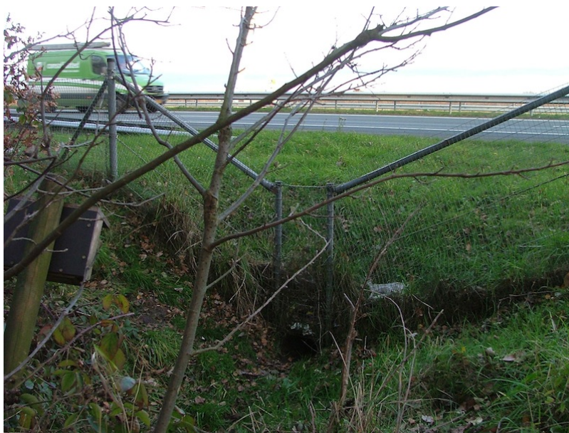
De dassentunnel onder de A27 ten zuiden van Hollandsche Rading. Links staat de camera, in een kastje.
