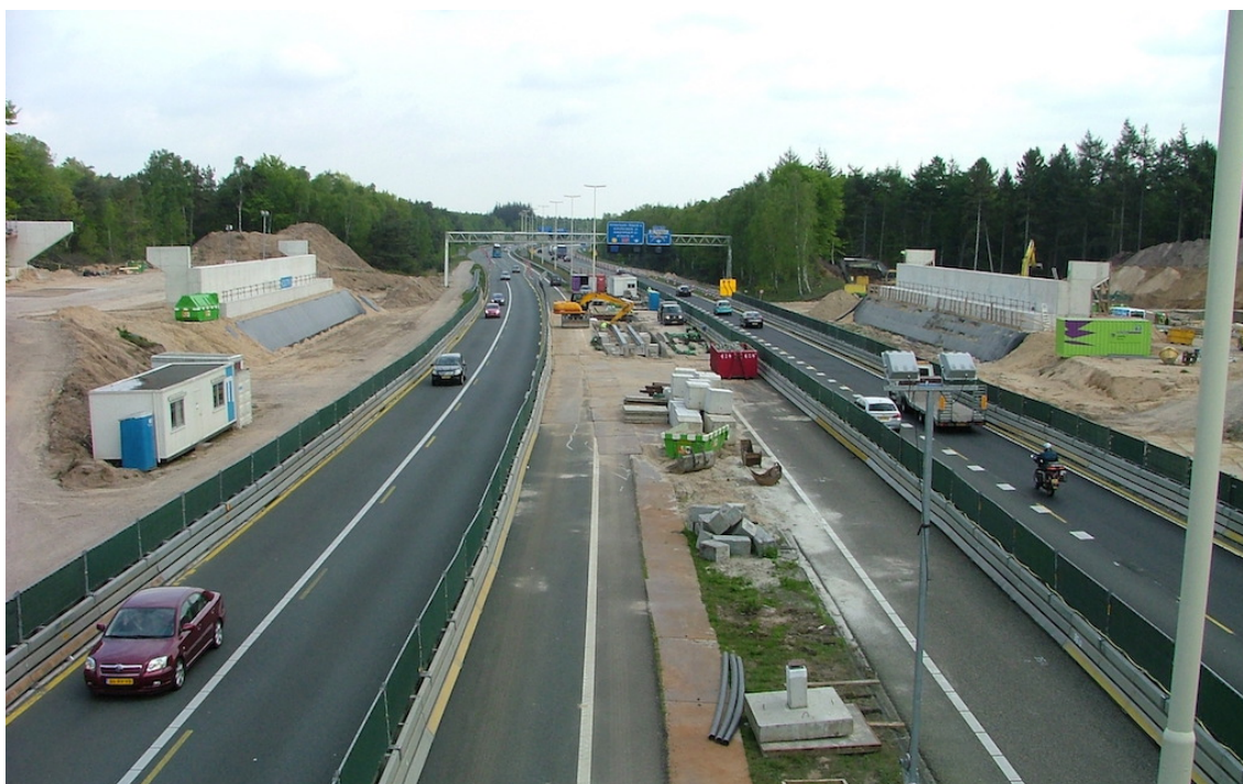
Aanleg van het ecoduct 'Zwaluwenberg' over de A27 bij Hilversum. 14 mei 2012
