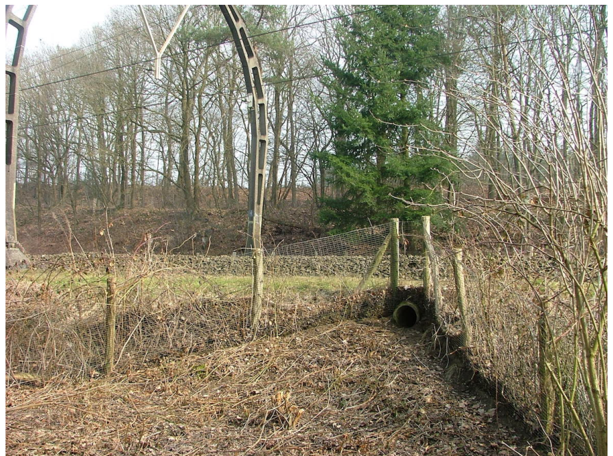
De dassentunnel onder het spoor bij Hollandse Rading, westkant, na een onderhoudsbeurt van de vegetatie.
