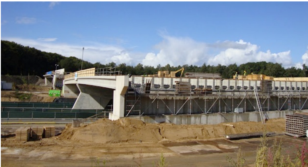
Ecoduct Zwaluwenberg in aanbouw, 19 september 2012. Op de voorgrond het deel over de A27, op de achtergrond het iets hogere deel over de spoorweg. Foto Nico Jonker.
